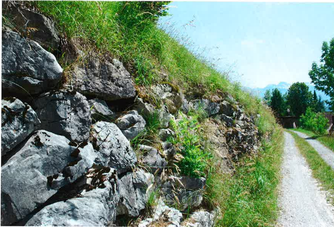
Abbildung 8: Strassenbord mit anstehendem Fels und geschichteten Natursteinen (Bruchsteinbau)
